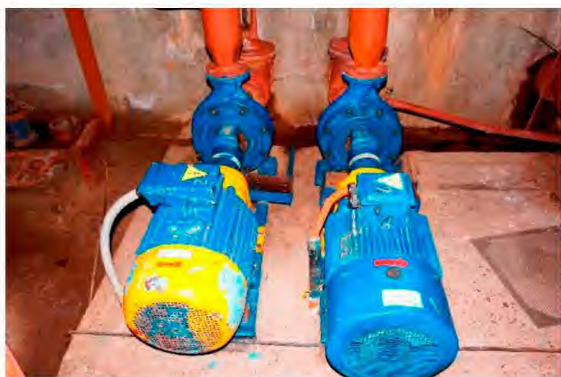
Рисунок 2.6 Визуальный осмотр насосных агрегатов марки СМ
