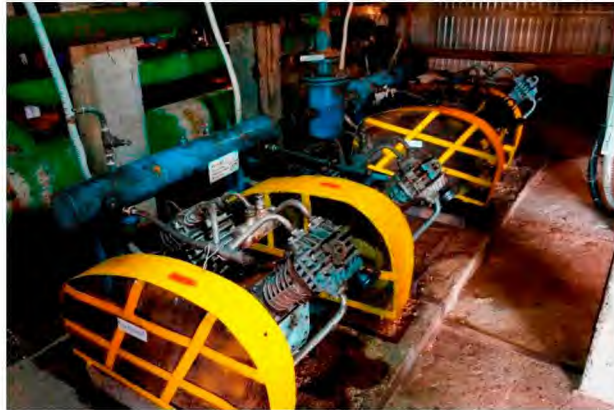
Рисунок 1.5 компрессорные головки подачи для нагнетания воздуха
