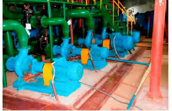
Рисунок 2.10. Аэрационные циркуляционные насосы
