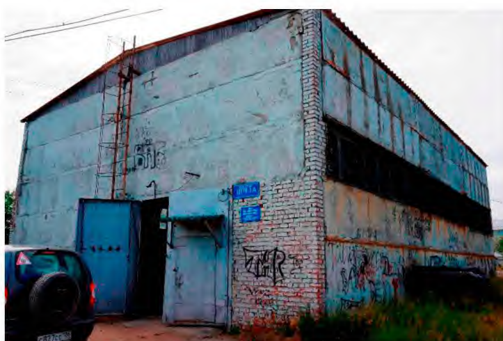
Рисунок 1.14 Визуальный осмотр здания ЦТП-1А
