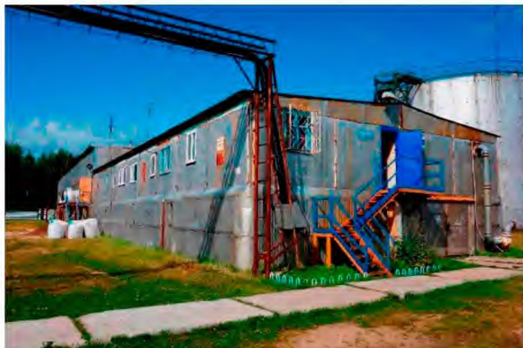
Рисунок 1.1 Визуальный осмотр здания ВОС-8000 г.п. Пойковский
