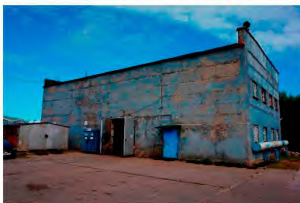
Рисунок 1.26 Визуальный осмотр здания ЦТП-5
