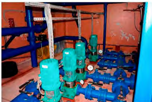
Рисунок 1.21 Визуальный осмотр ЦТП-3А: насосы ХВС – 4 шт., , насосы ГВС – 5 шт. и корректирующие насосы (по отоплению) – 2 шт.
