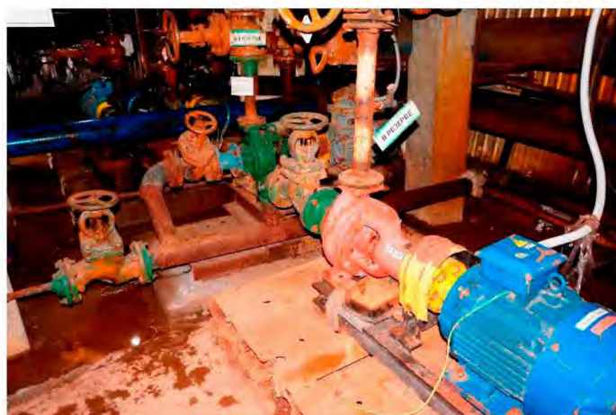
Рисунок 1.9. Шламный насос для удаления воды после промывки ФОВ
