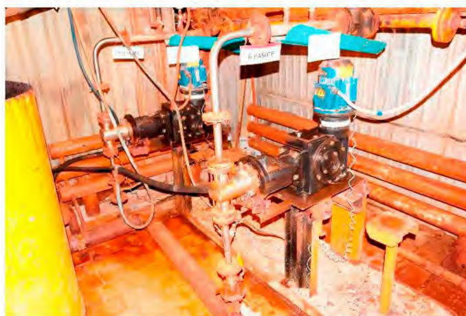
Рисунок 1.10 Насосы-дозаторы гипохлорита кальция в РЧВ
