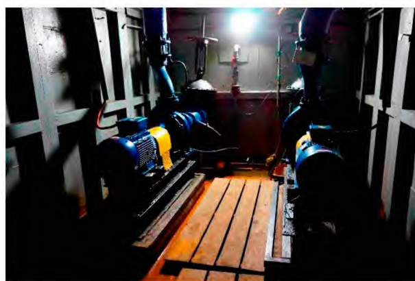
Рисунок 2.4 Визуальный осмотр здания КНС-4 и насосных агрегатов марки СМ
