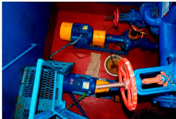
Рисунок 2.3 Визуальный осмотр здания КНС-3 и насосных агрегатов марки СМ
