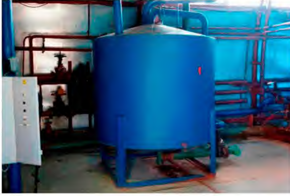
Рисунок 2.9. Бак-усреднитель
