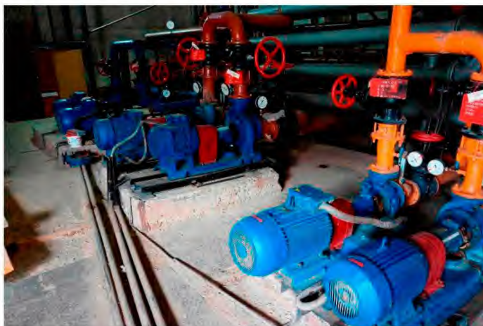
Рисунок 1.24 Визуальный осмотр ЦТП-4: насосы ХВС – 2 шт., , насосы ГВС – 2 шт. и корректирующие насосы (по отоплению) – 2 шт.
