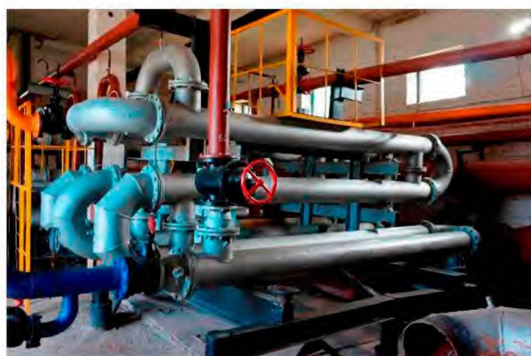
Рисунок 1.33 Визуальный осмотр ЦТП-7: теплообменник подготовки ГВС
