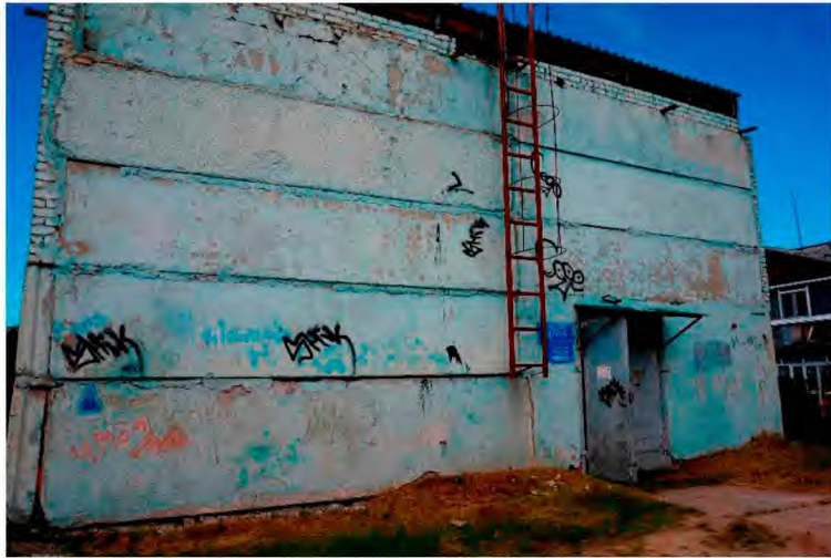
Рисунок 1.11 Визуальный осмотр здания ЦТП-1
