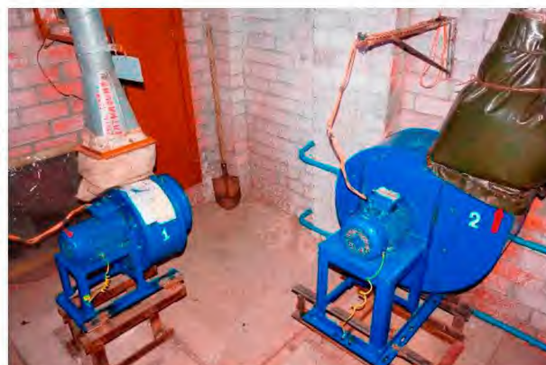
Рисунок 2.5 Визуальный осмотр здания КНС-4 и приточно-вытяжной вентиляции
