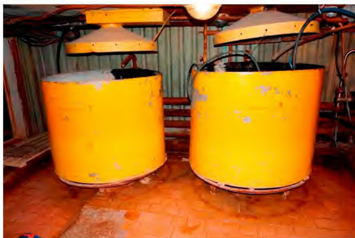
Рисунок 1.8 Визуальный осмотр баков готового раствора гипохлорида кальция для подачи в РЧВ
