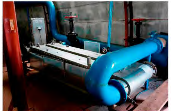
Рисунок 2.12. Установка УДВ, 1-я очередь
