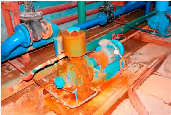
Рисунок 2.11. Блок обезвоживания: компрессор ВК
