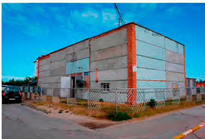
Рисунок 1.23 Визуальный осмотр здания ЦТП-4
