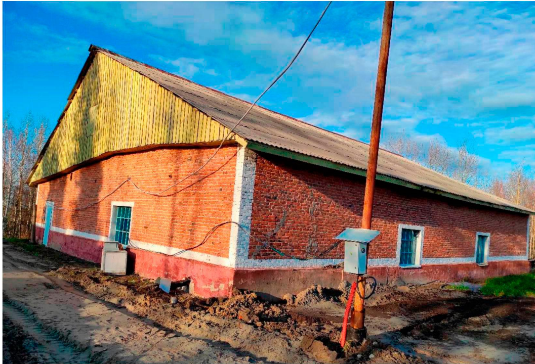
Канализационные очистные сооружения КОС-400. Здание.
