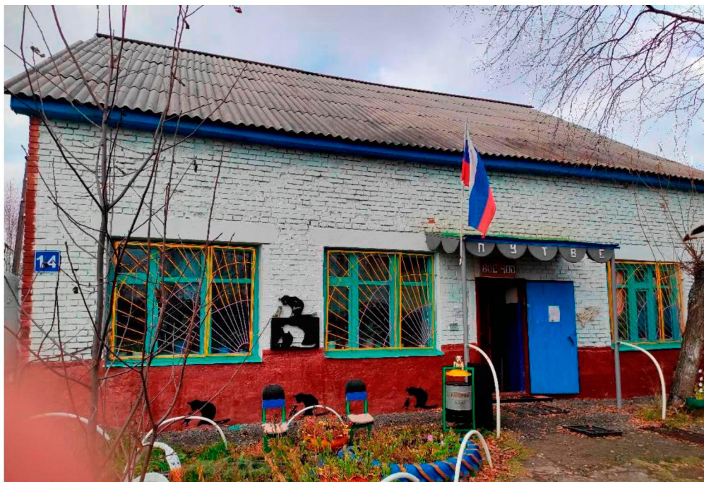
Станция обезжелезивания ВОС-400. Здание
