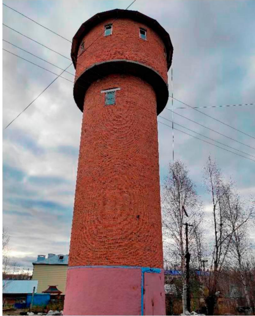
Водонапорная башня V 100м 3 .
