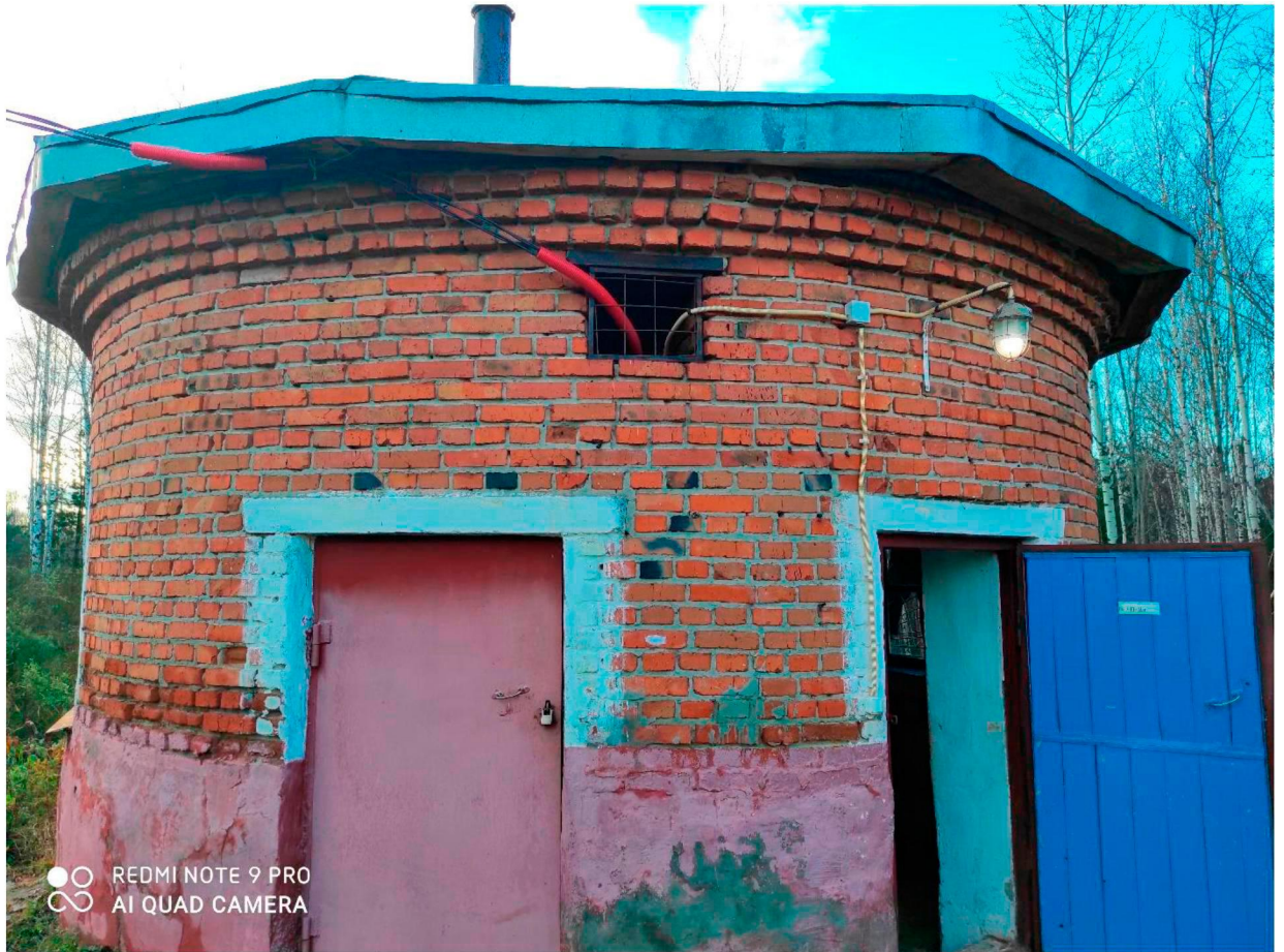
Канализационная насосная станция (КНС). Здание.
